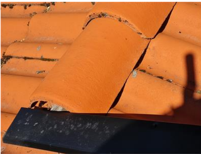
Horisontell bjälke exponerad på lägre tak.
