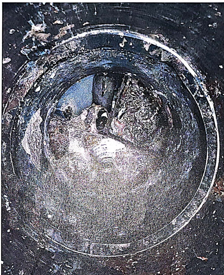
Bild 2: Slamavskiljare med tecken på slamflykt
