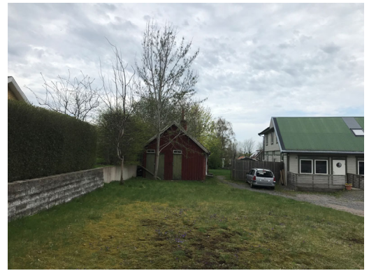
Befintlig stödmur i fastighetsgräns mot Tröinge 6:71
