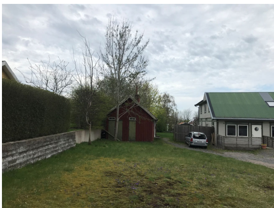
Stödmur i fastighetsgräns i söder
