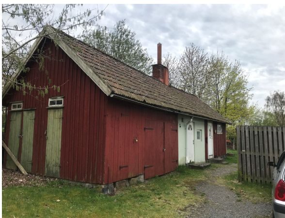
Befintligt uthus som avses rivas
