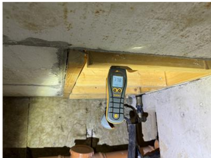
Fuktkvotsmätning i krypgrunden
