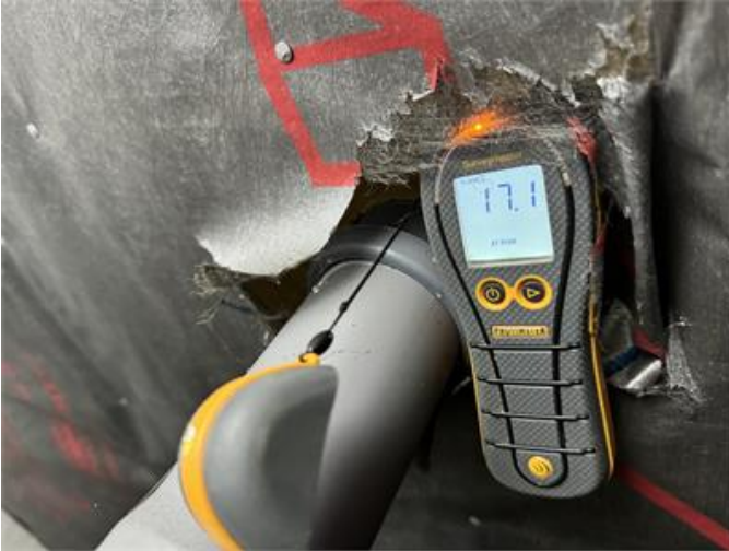
Fuktkvotsmätning i kryppgrund
