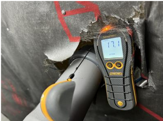
Fuktkvotsmätning i kryppgrund
