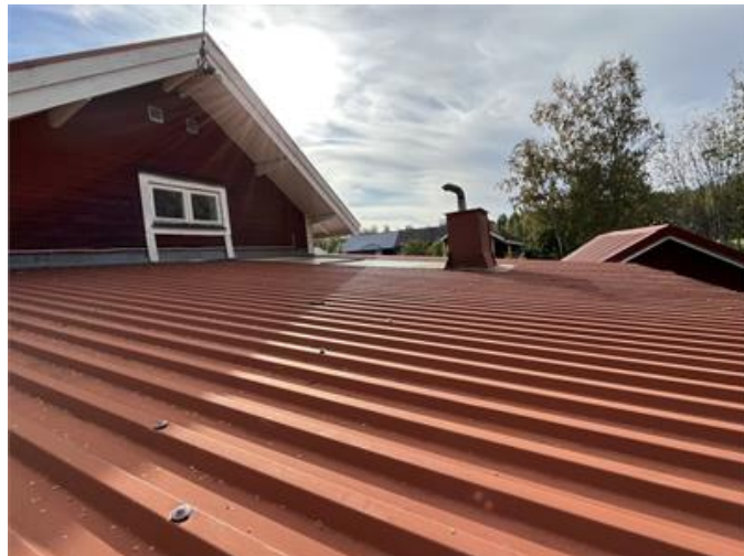
Låglutande plåttak med äldre klockspikar.
