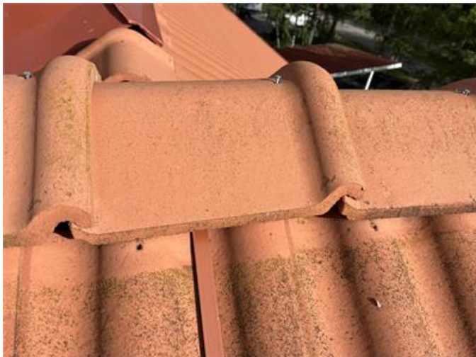
Bilden visar nockpannor och översta panraden på tak.
