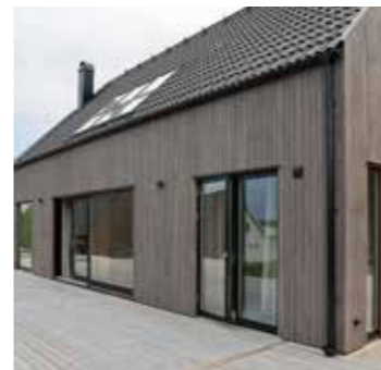
UTAN KNUT VID SPÅRPANEL UTVÄNDIGT MODERN FODER- BILDANDE SALNING FÖNSTER UTAN SPRÖJS
