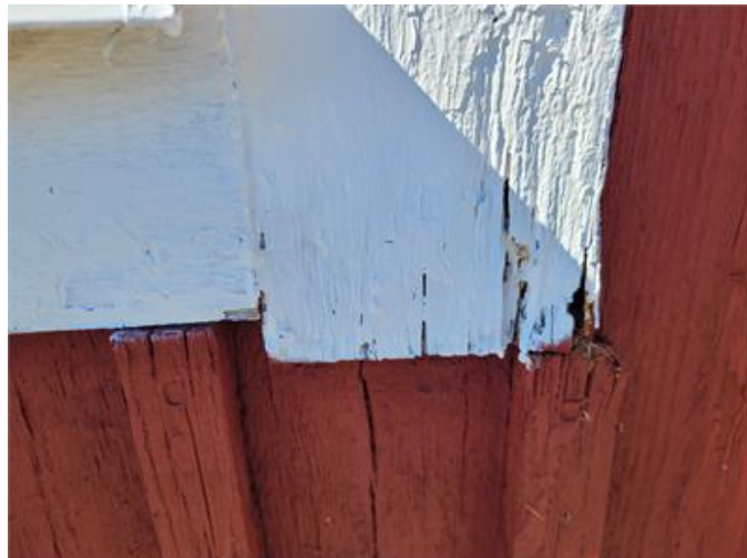
Rötskadad fasadpanel
