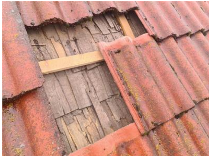
Tak, underlagstak av sk takspån.
