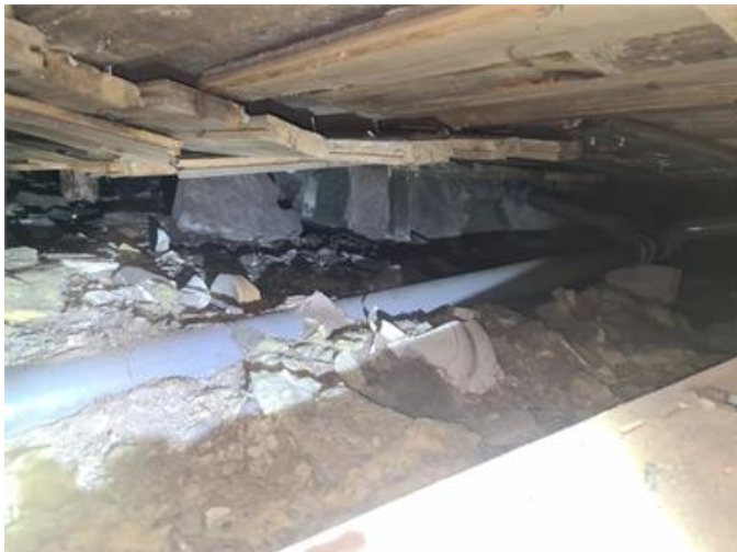
Torpargrund, översiktsbild från luckan i golvet i Hall.
