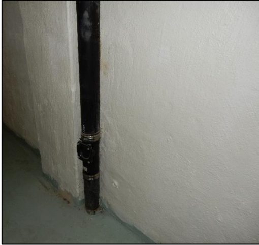
Utbytt spillvattenledning
