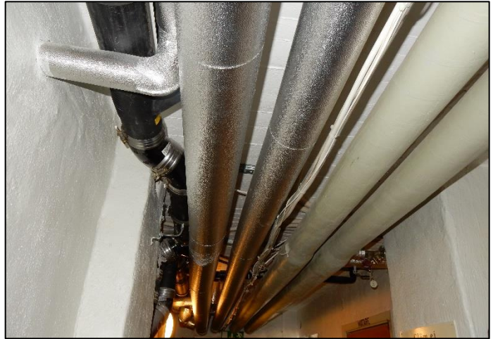
Spillvattenledning och vattenstråk
