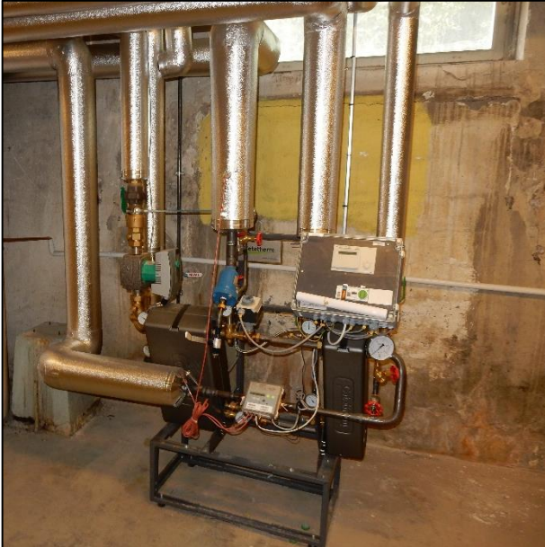
Fjärrvärmeväxlare
