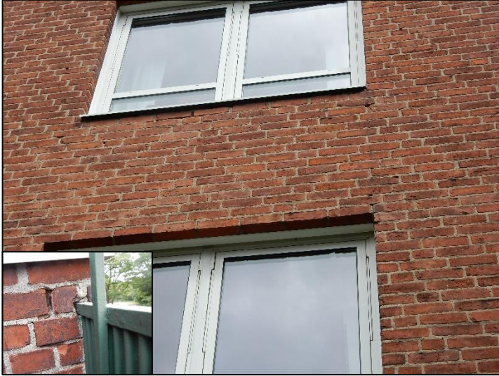
Frostskador tegelfasad
