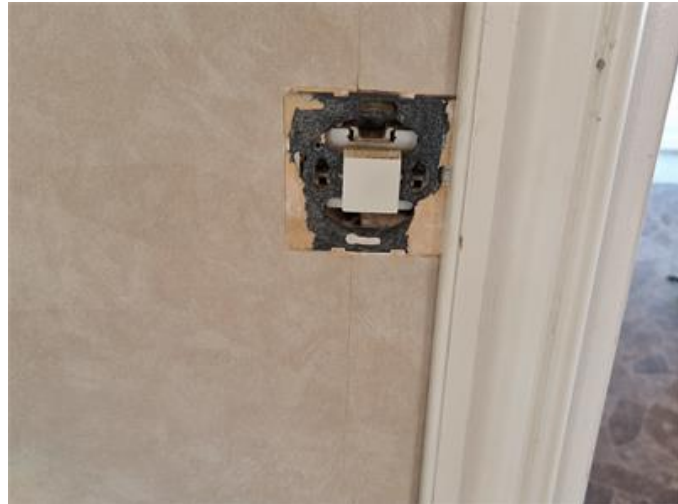
Sovrum 1: Strömbrytare saknar skyddshölje
