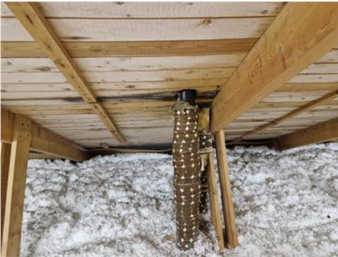
Vy på vindsutrymmet
