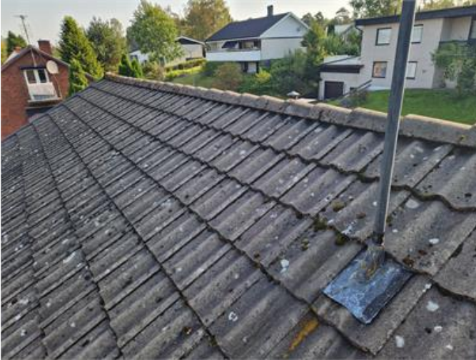
Vy på yttertak
