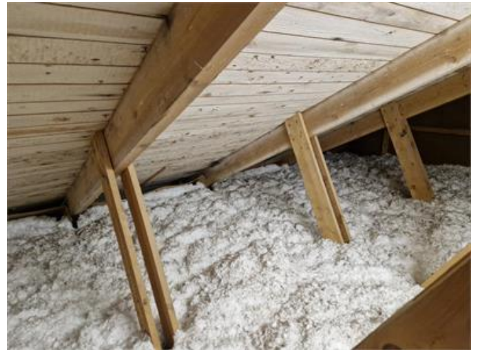
Vy på vindsutrymmet
