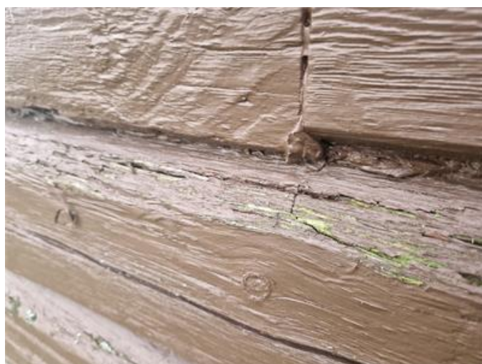
Rötskador noteras
