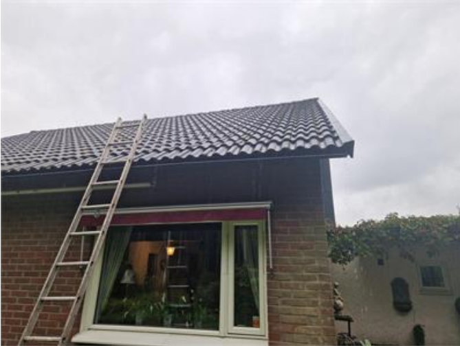
Vy på yttertak
