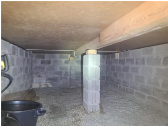
Krypgrund, översiktsbild mot sydöst.
