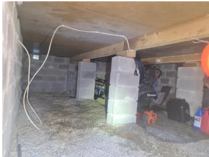
Krypgrund, översiktsbild mot väst.
