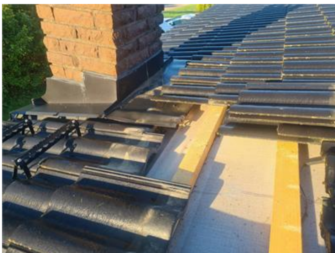
Tak, underlagstak av armerad plasfolie ovan träfiberskivor.
