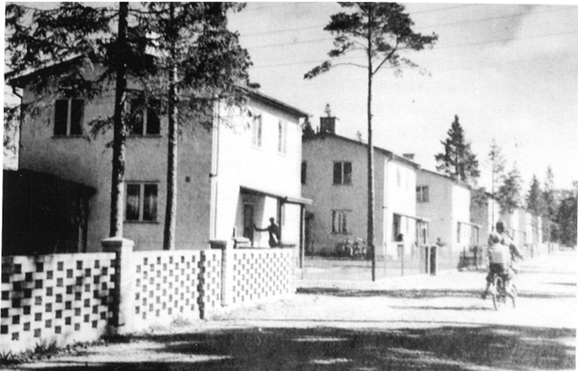
Ugglevägen med nybyggda enfamiljshus – notera de specialritade skärmtaken. Foto Harry Dittmer.
