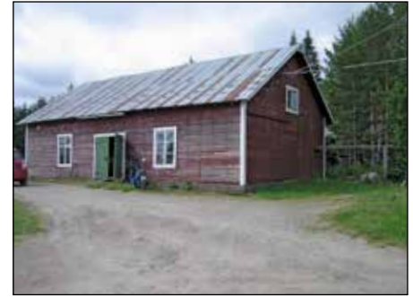
Salteriet från 1935 är en relativt stor byggnad i resvirke och liggande panel.
