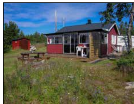
Fiskarstuga med fasader i liggande fjällpanel och en nyare tillbyggnad med inglasning.
