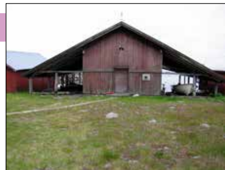
Båthus och sjöbod med stora, utskjutande tak, svalar på båda sidor fungerande som väderskydd vid båtförvaring.
