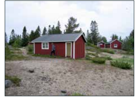
Holmstugan med inskription från 1895 är en liten och lågt byggd stuga med stående locklistpanel på den timrade stommen
