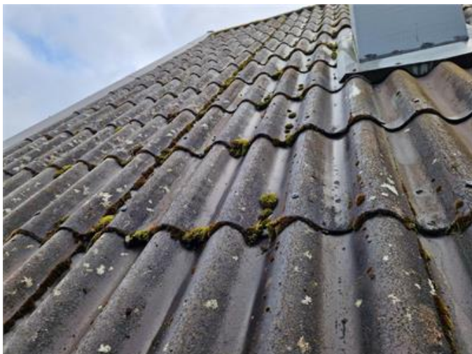
Vy på yttertak
