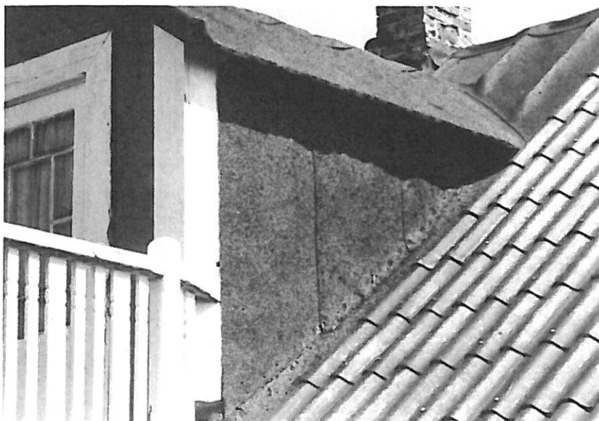
Fig 13. Varierande takbeklädnad på parhus. Papp- och betongtak.
