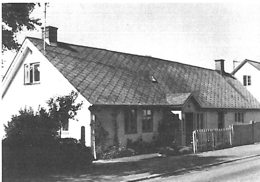
Fig 6. Hus byggt före 1860 innehållande 3 lägenheter.
