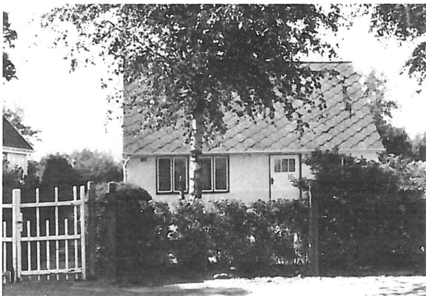
Fig 3. Hus byggt före 1860 med måttliga förändringar.
