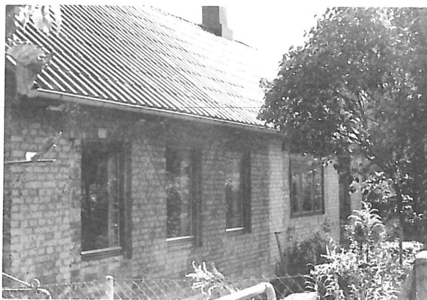
Fig 34. ... får ett helt nytt utseende genom att takmaterialet byts ...
