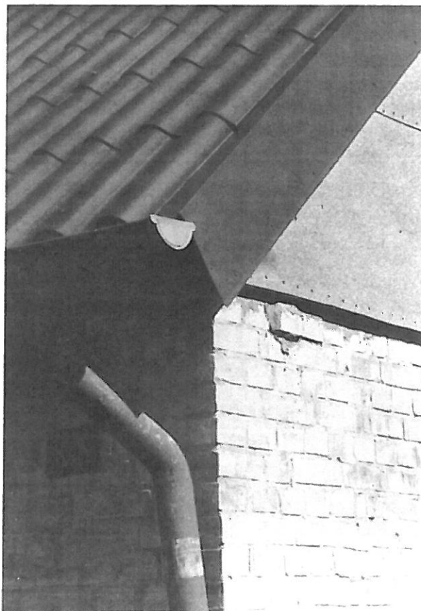
Fig 39. Ny takbeläggning och vindskiva av plåt.
