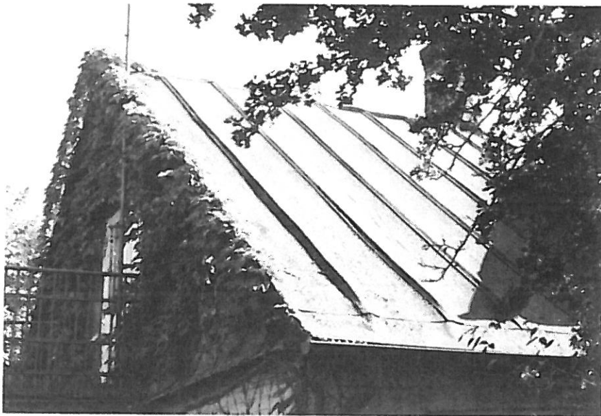
Fig 36. Hus med ursprunglig taktäckning av papp.
