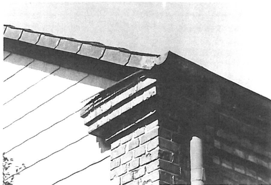
Fig 38. Takfot och vindskiva utförda av de för Lomma typiska materialen tegel resp eternit.
