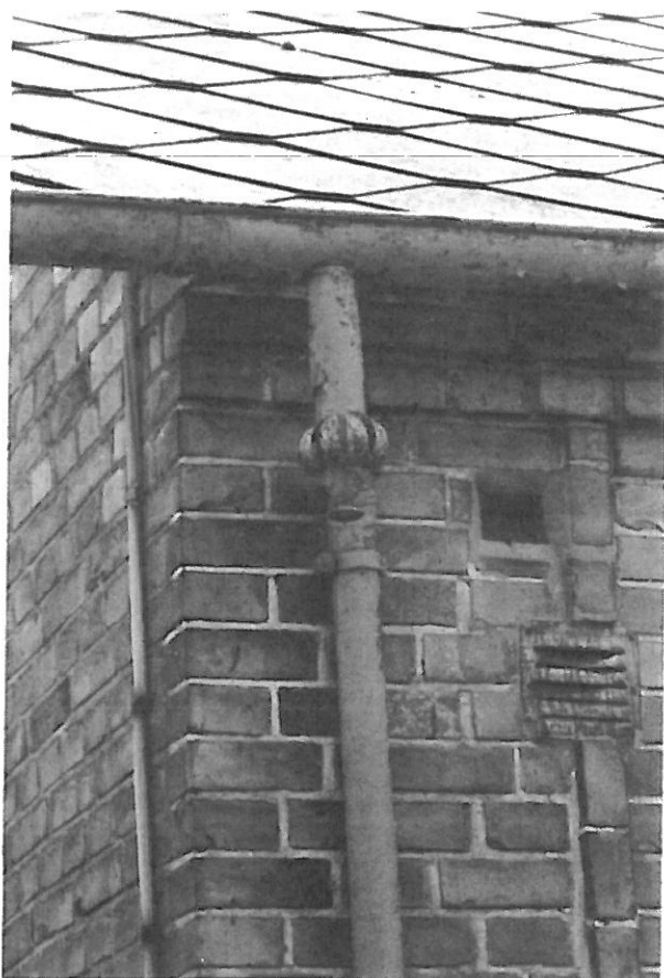
Fig 42. Detalj av stuprör.
