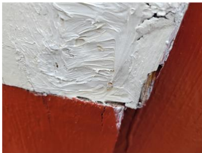
Rötskadad fasadpanel
