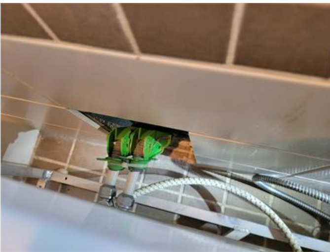
Rör genomföring i golv.
