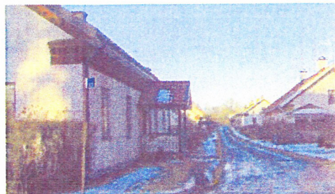
Bruksgata med de f d arbetarbostäderna.
