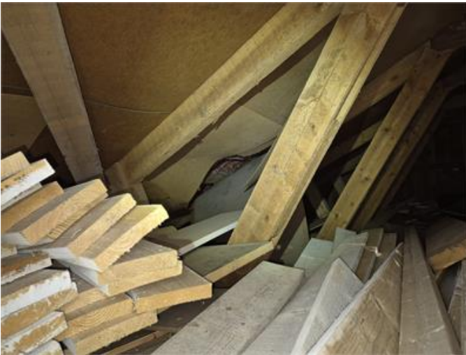
Bild från vinden ovanför garaget.
