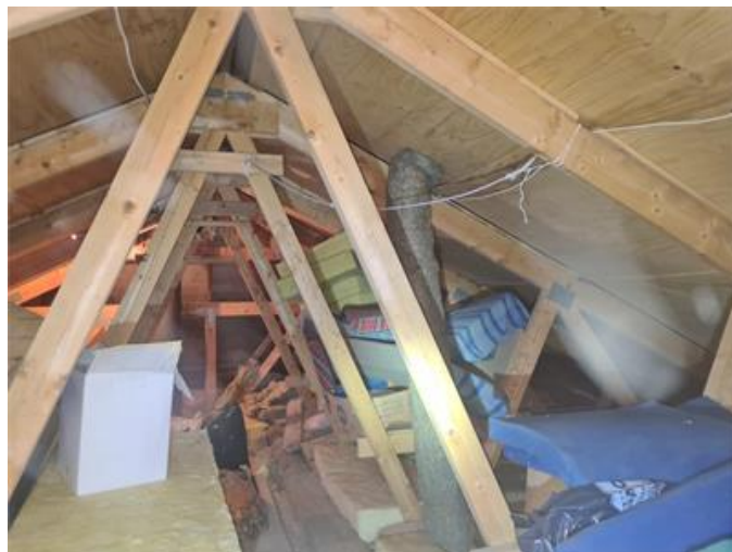
Nockvind, underlagstak av träfiberskivor utan ovanliggande underlagspapp.
