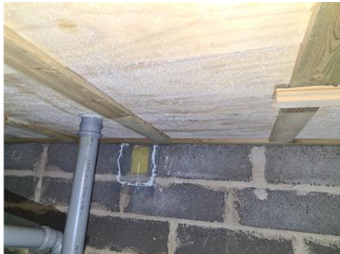
Krypgrund, vitaktig mikrobiell påväxt på blindbottenskivor.
