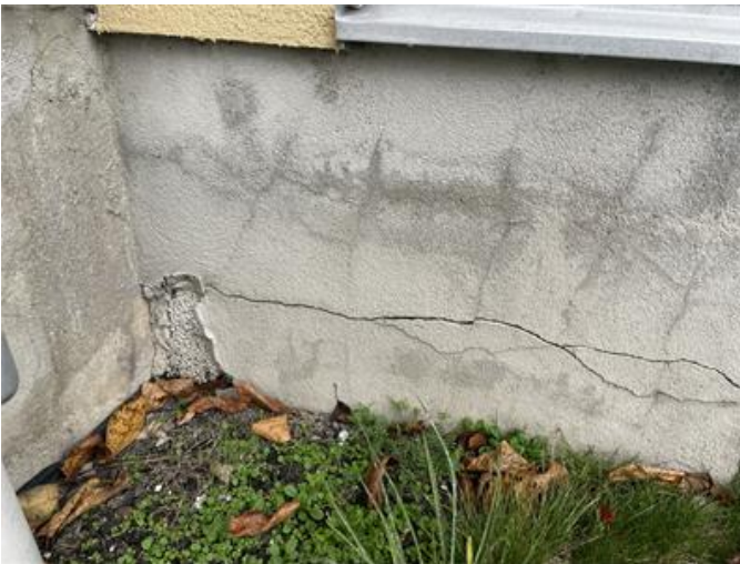
Grund med underhållsbehov.
