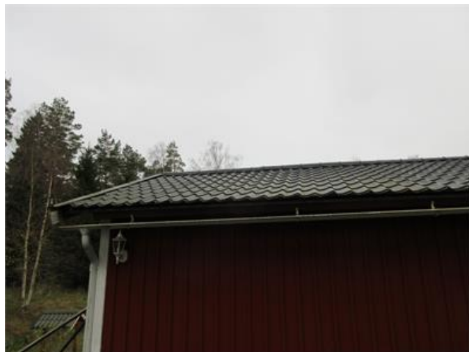
Långt avstånd mellan hängränna och tak samt mellan rännkrokar
