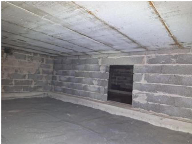
Krypgrund, översiktsbild södra delen.
