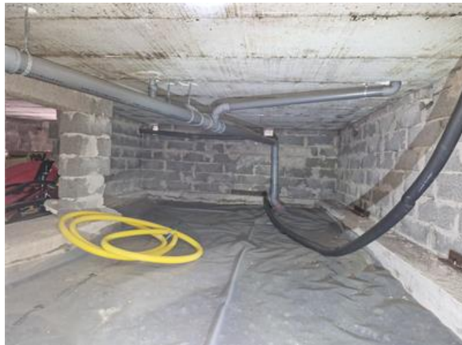
Krypgrund, översiktsbild norra delen.
