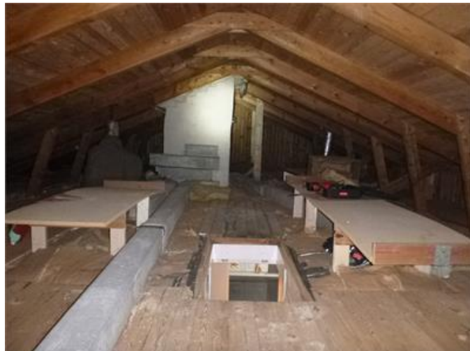
Bilden visar vy av vind.
