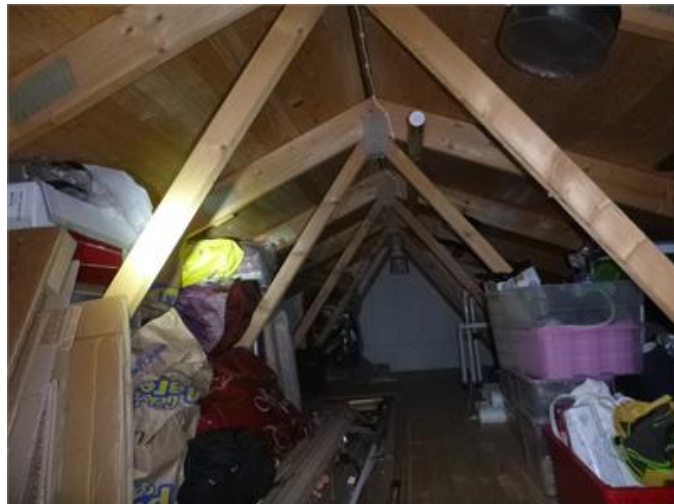
Bilden visar vy av vind.
