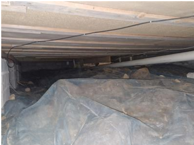
Vy i krypgrund
