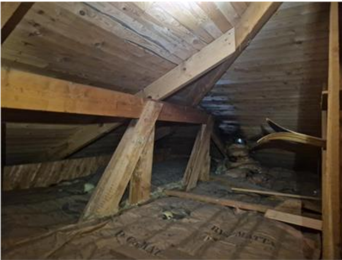
Vy på vindsutrymmet
