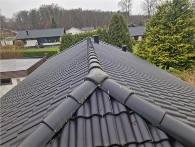
Vy på yttertak
