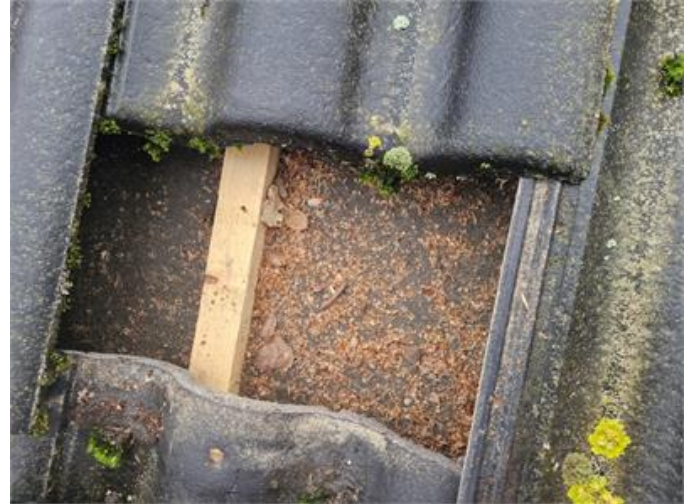
Vy på underlagstak
