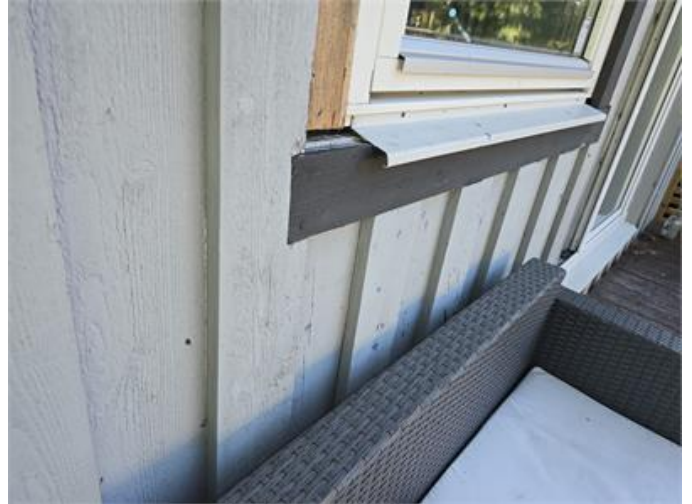
Exempel på otätheter i fasad.
