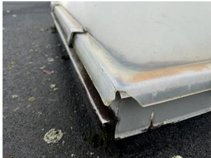
Takkupol sprucken mot sarg.
