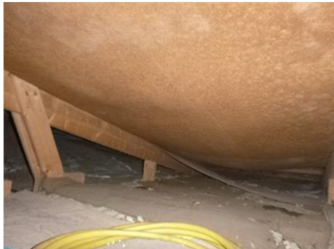
Bilden visar vy av vind (garage).
