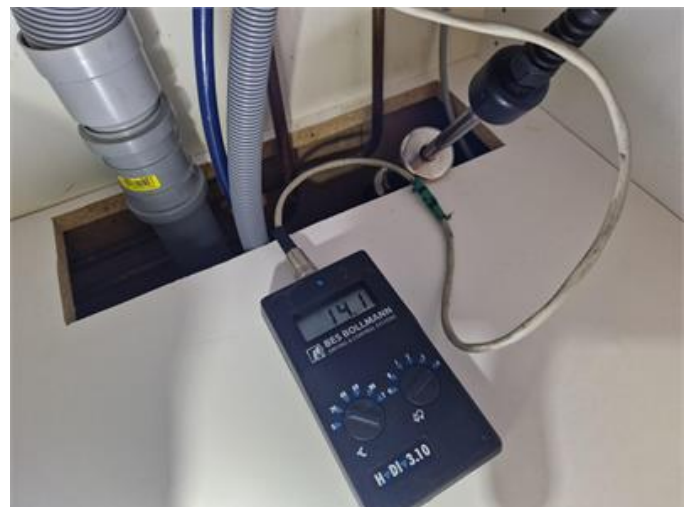
Referensmätning i köksskåp mot väggskiva/syll.
