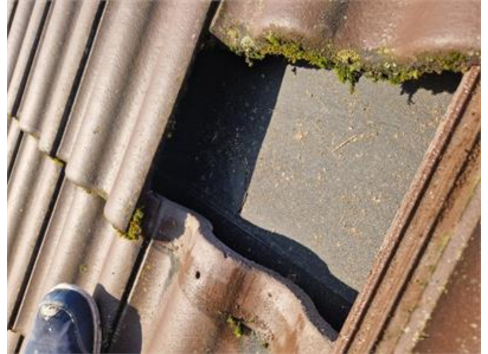
Vy på underlagstak
