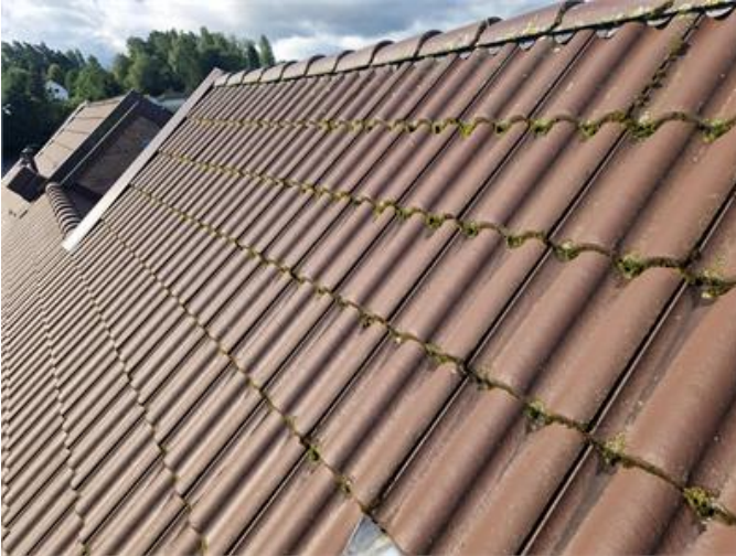
Vy på yttertak
