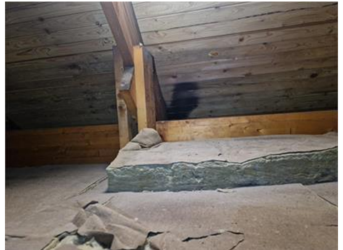
Lokala mikrobiella påväxter noterades på underlagstak
