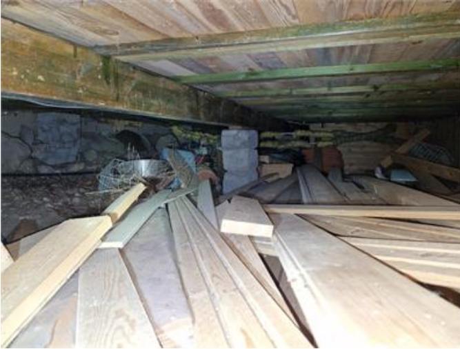
Krypgrund ursprunglig del från luckan på norra gaveln
