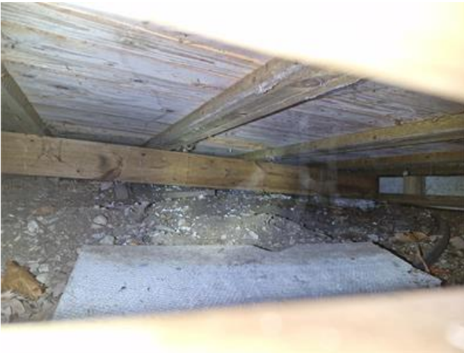
Plintgrund västra utbyggnaden.
