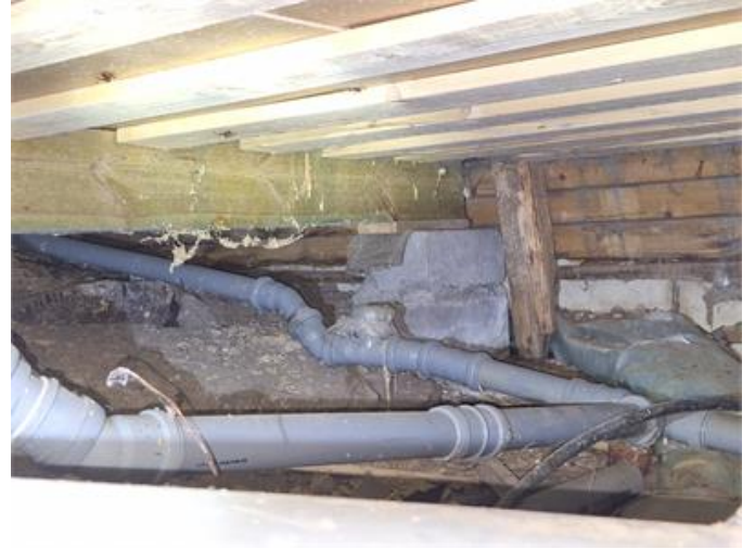
Krypgrund ursprunglig del från luckan söder vid vvb.
