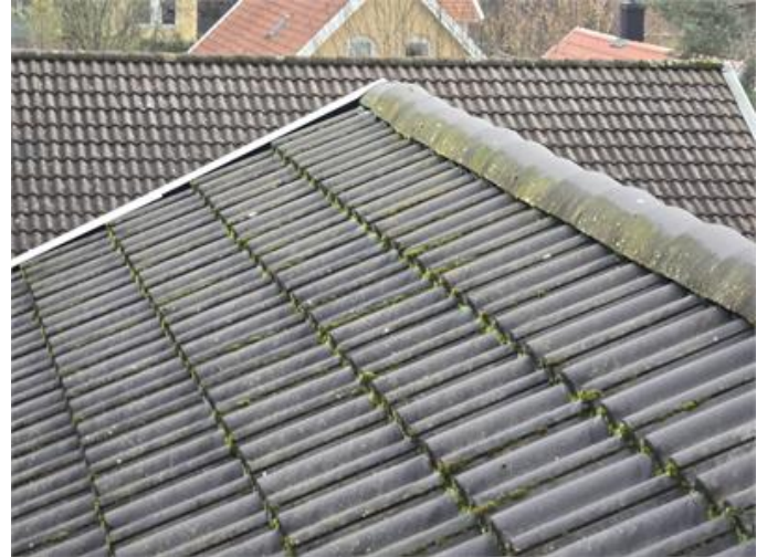
Del av yttertak.
