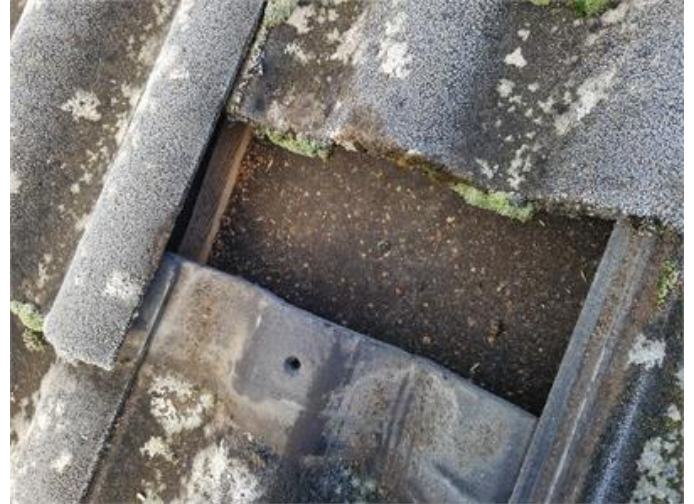
Vy på underlagstak
