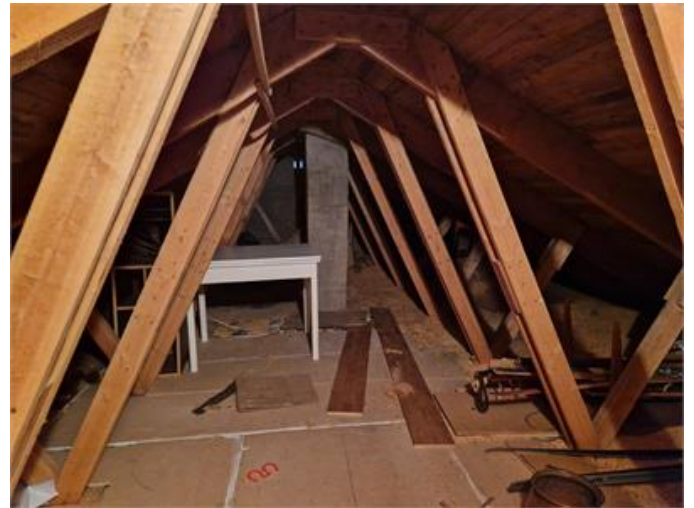
Vy på vindsutrymmet
