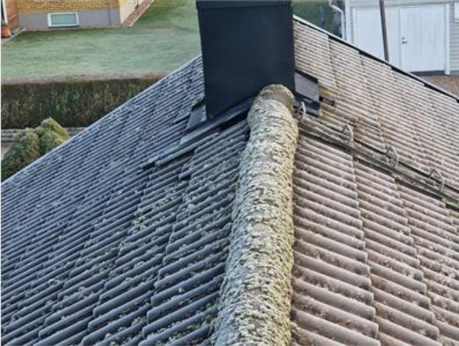
Vy på yttertak
