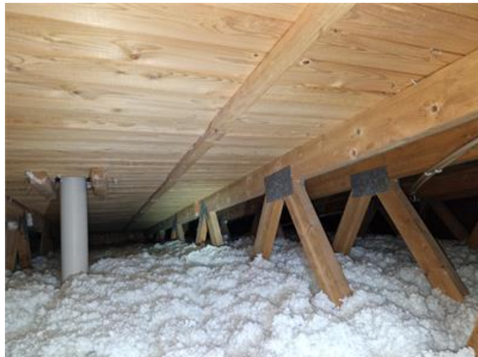
Nockvind, översiktsbild mot östra delen.
