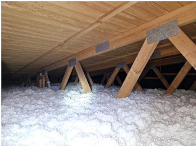
Nockvind, översiktsbild mot västra delen.
