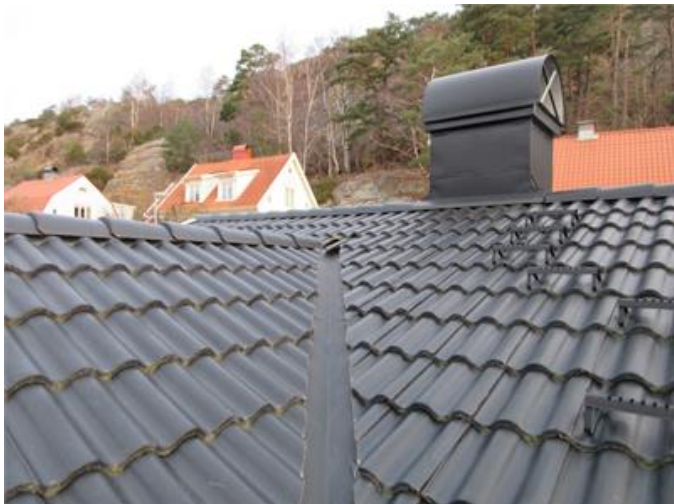
Pannor täcker bitvis bristfälligt i ränndalar
