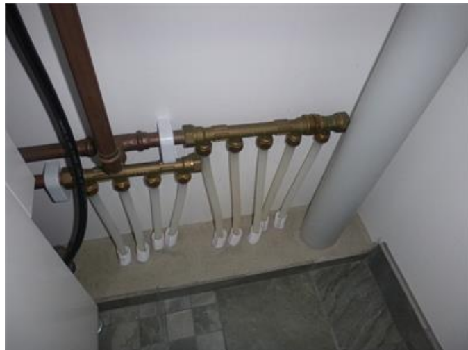
Bilden visar uppgjuten klack där tätskikt inte finns.
