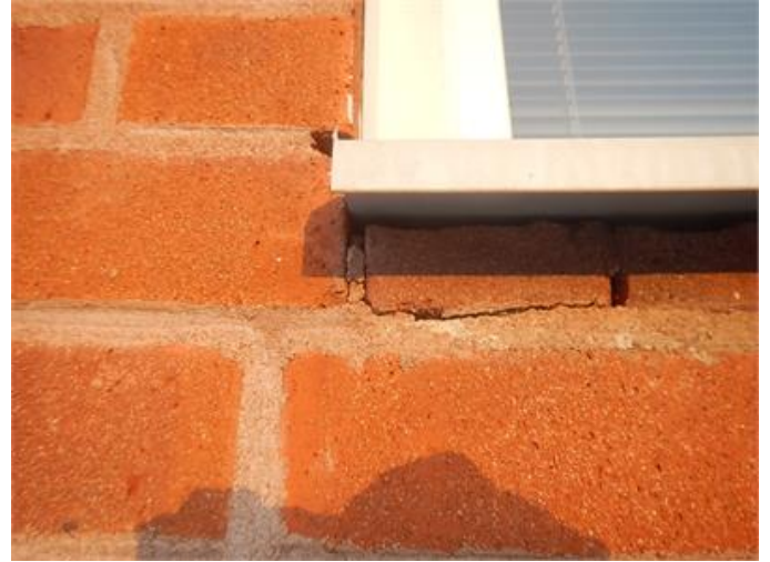
Tegel som släppt i infästning.
