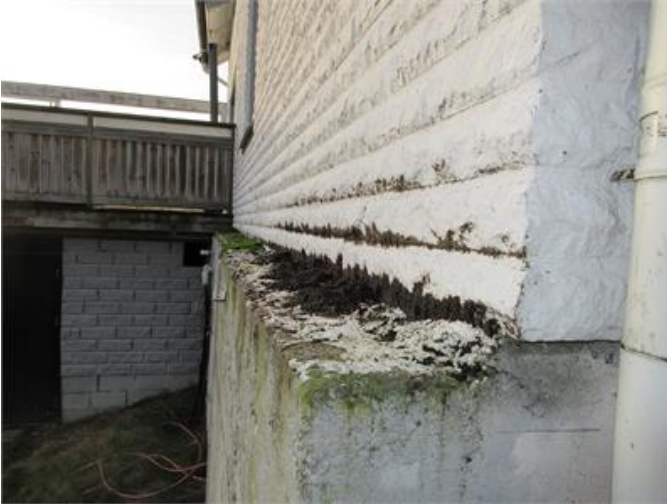
Tegelfasad monterat innanför grundmur/sockel
