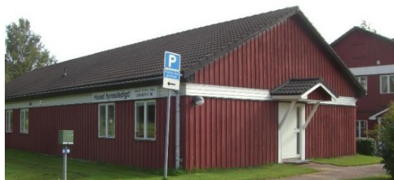
Hus B, fasad mot parkering
