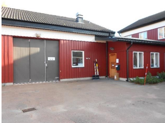
Hus C-D, fasad mot gården
