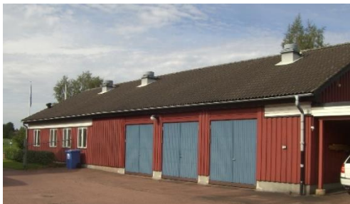
Hus B, fasad mot gården
