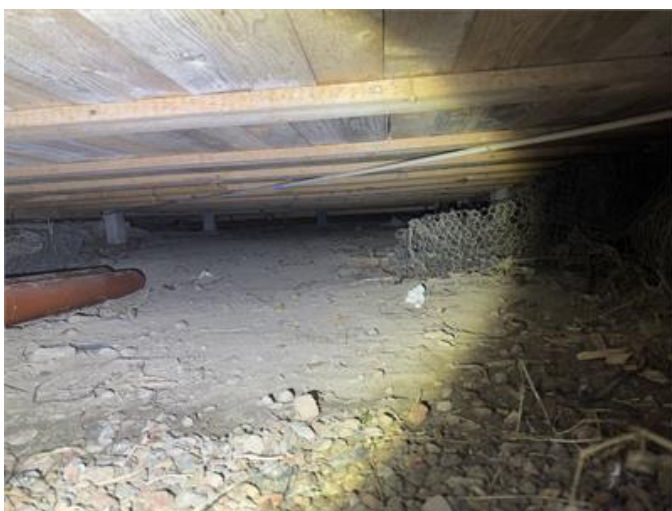
Bild visar del av plintgrund, bild tagen från öppning vid gavel.
