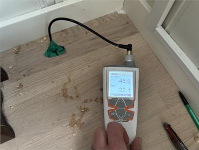
Mätning av relativ fuktighet i uppreglat golv.
