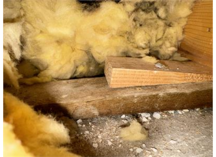
Träskyddsbehandlat virke i uppreglad golvkonstruktion.
