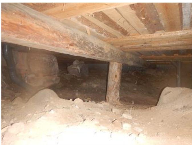
Vy över krypgrund.
