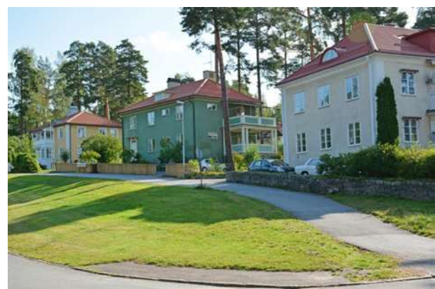
TIVOLIGATAN DÄR MAN TYDLIGT SER BYGGNADERNAS ENHETLIGA FORMER I TVÅ VÅNINGAR MED VALMADE RÖDA TAK.
