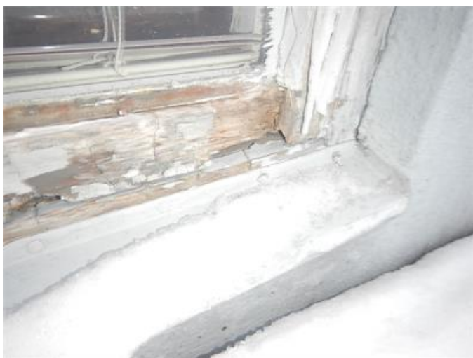
Rötskadat källarfönster.
